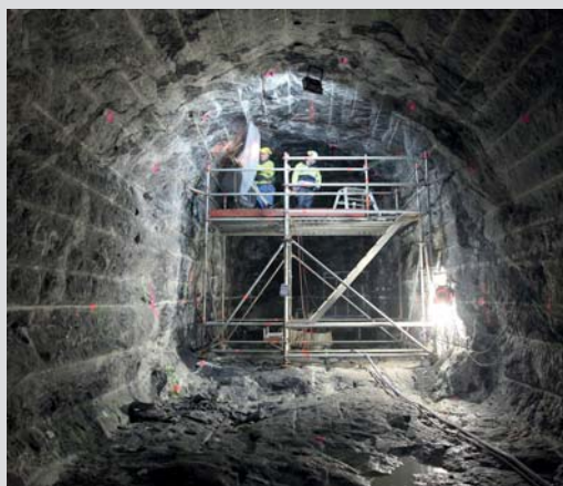
Hloubení finské podzemní laboratoře (Zdroj: Posiva; fotograf: Jussi Partanen)
