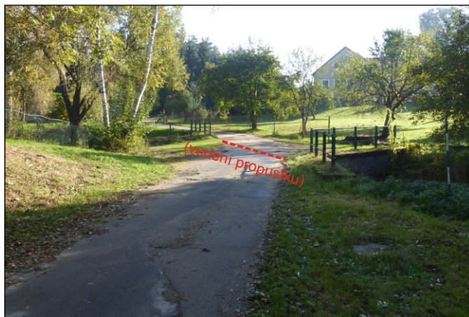
Propustek 1c - staničení 0,052 - celkový pohled
