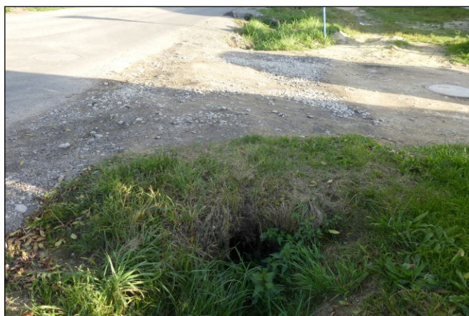
Propustek 25c - staničení 0,002 - pohled zprava
