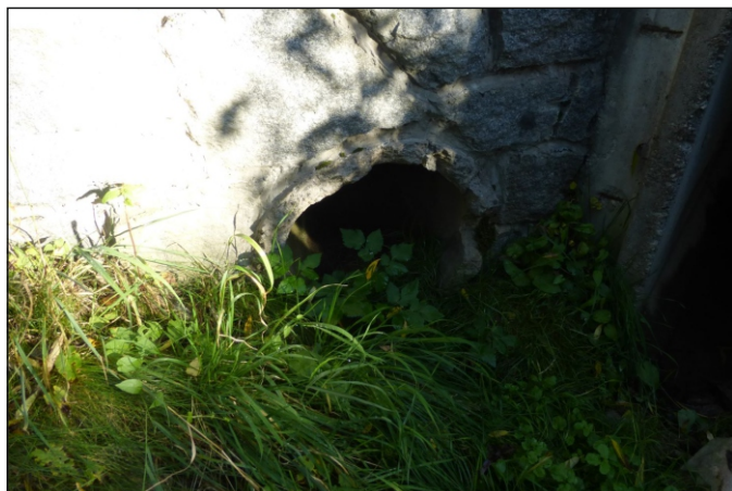
Propustek 1c - staničení 0,045 - pohled zprava
