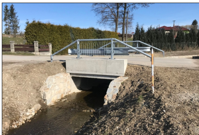
Most 12c-M1 - staničení 0,067 - pohled zleva
