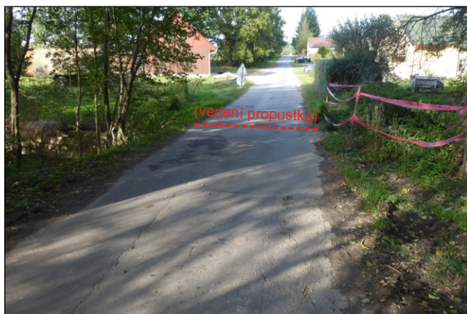
Propustek 1b - staničení 0,295 - celkový pohled
