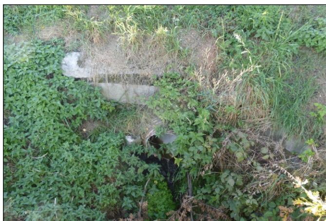
Propustek 1b - staničení 0,593 - pohled zleva
