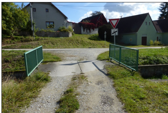
Most 11c-M1 - staničení 0,008 - celkový pohled
