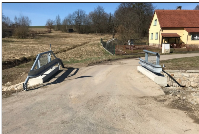
Most 15c-M2 - staničení 0,264 - celkový pohled
