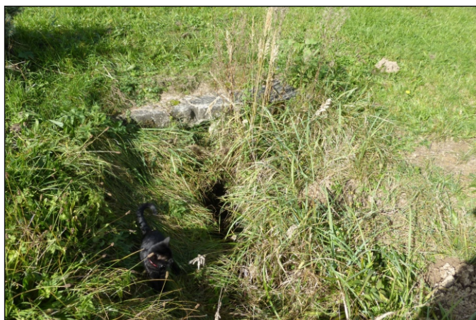
Propustek 10c - staničení 0,250 - pohled zprava
