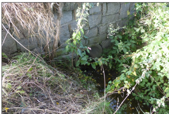
Propustek 22c - staničení 0,553 - pohled zleva
