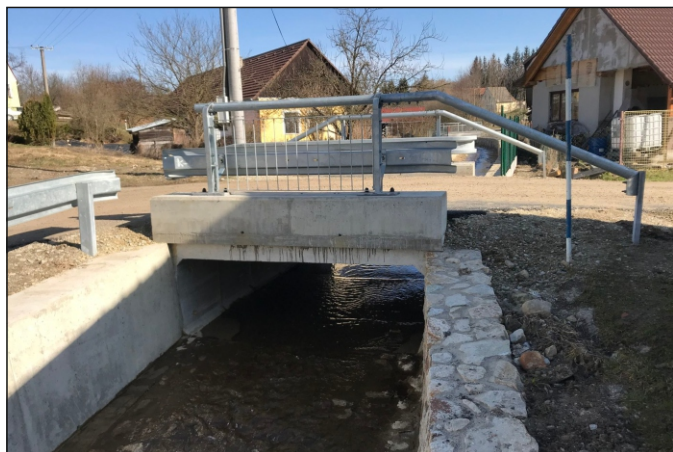
Most 14c-M1 - staničení 0,032 - pohled zleva
