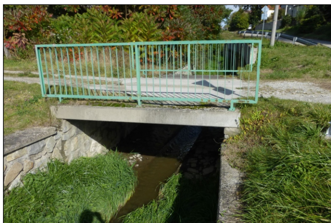
Most 11c-M1 - staničení 0,008 - pohled zleva
