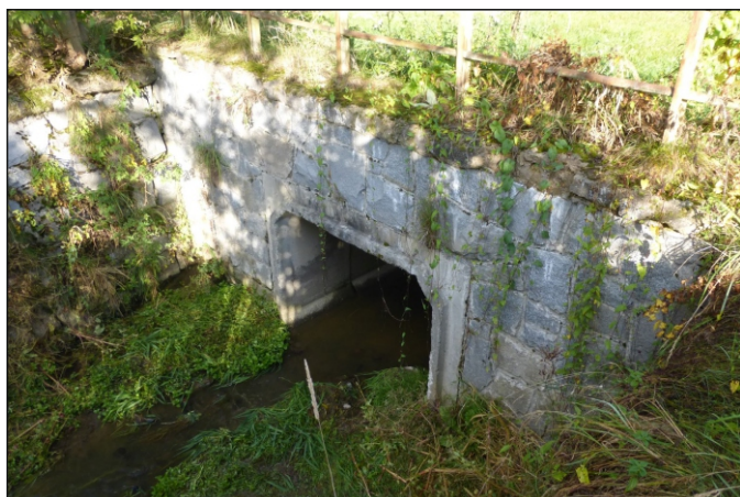
Propustek 1c - staničení 0,377 - pohled zleva
