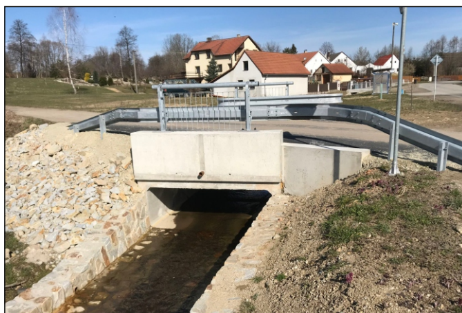
Most 18c-M1 - staničení 0,010 - pohled zleva
