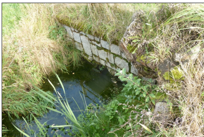
Propustek 22c - staničení 0,553 - pohled zprava
