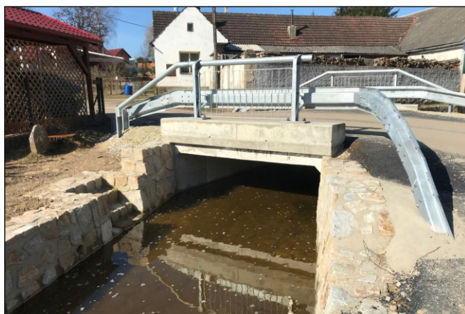
Most 15c-M1 - staničení 0,025 - pohled zleva
