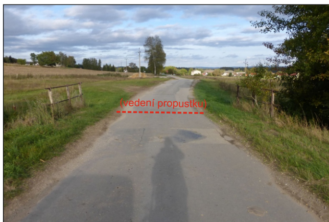
Propustek 22c - staničení 0,553 - celkový pohled
