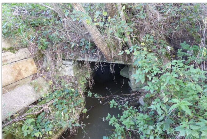
Propustek 1b - staničení 0,295 - pohled zprava
