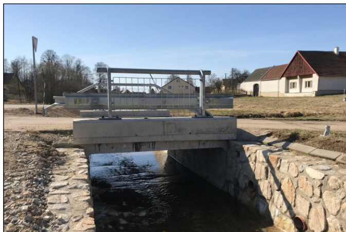
Most 15c-M2 - staničení 0,264 - pohled zleva
