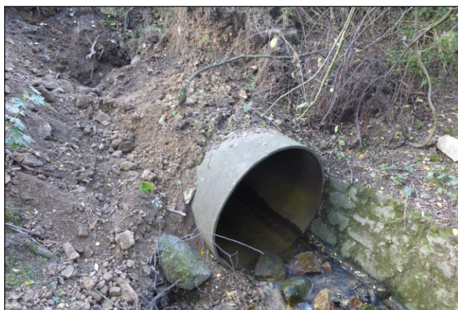
Propustek 1b - staničení 0,295 - pohled zleva
