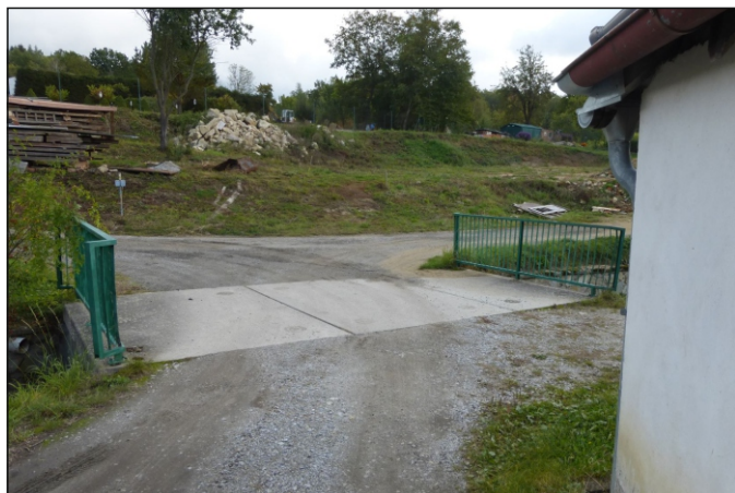
Most 7c-M1 - staničení 0,043 - celkový pohled
