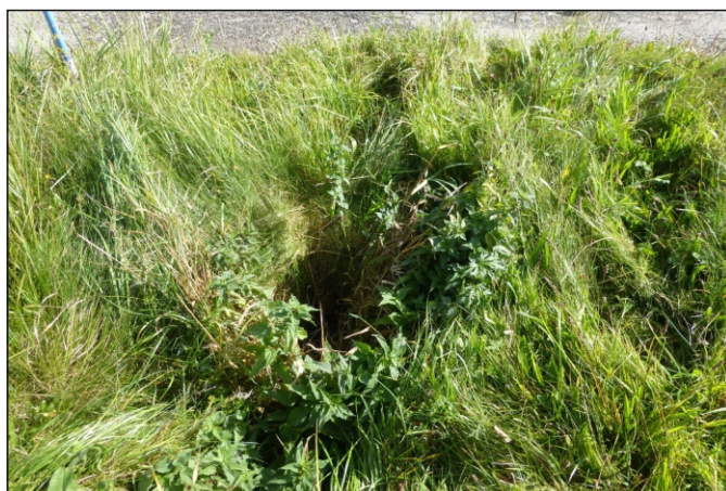
Propustek 10c - staničení 0,250 - pohled zleva
