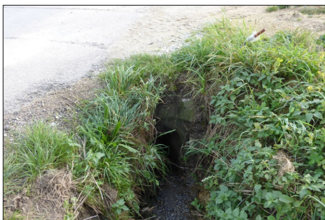
Propustek 24c - staničení 0,001 - pohled zprava
