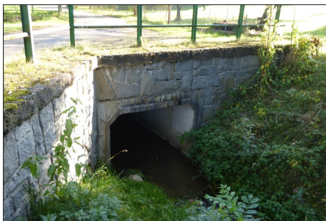
Propustek 1c - staničení 0,052 - pohled zprava
