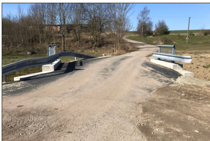
Most 18c-M1 - staničení 0,010 - celkový pohled
