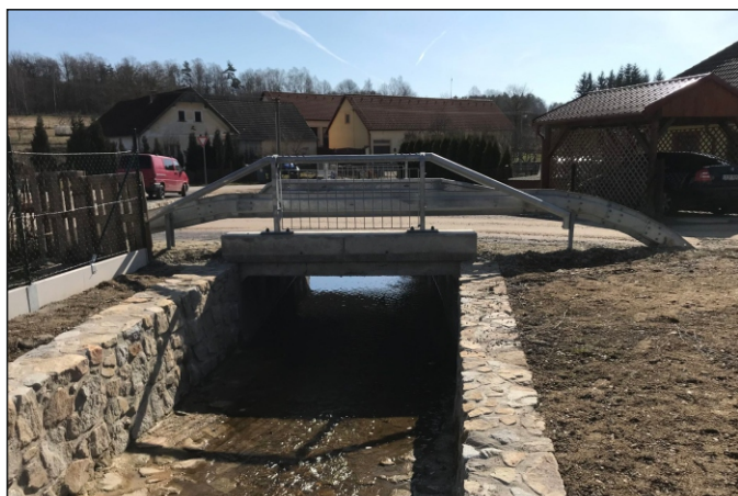
Most 15c-M1 - staničení 0,025 - pohled zprava
