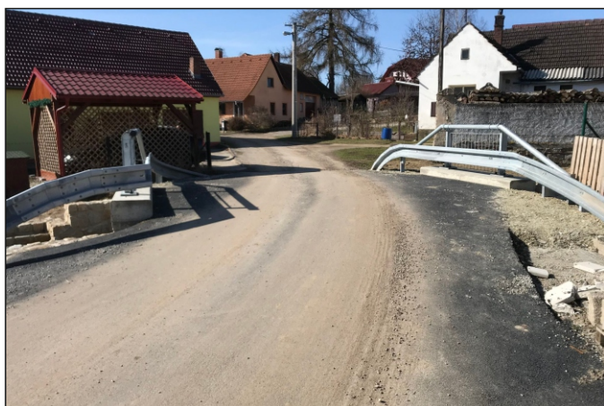
Most 15c-M1 - staničení 0,025 - celkový pohled
