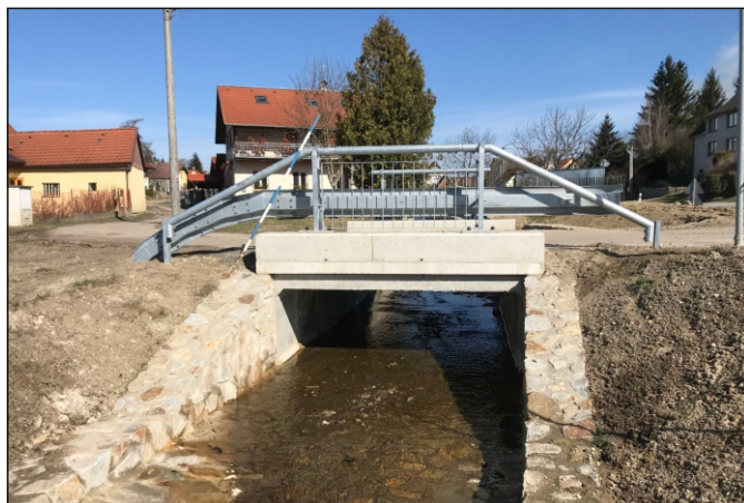
Most 15c-M2 - staničení 0,264 - pohled zprava
