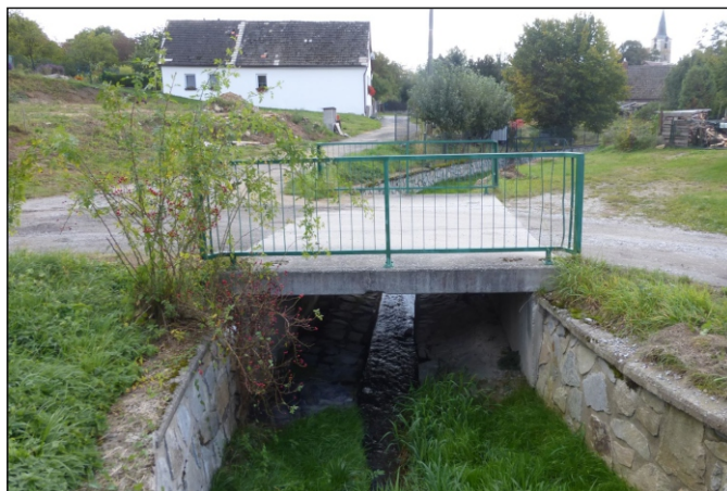
Most 7c-M1 - staničení 0,043 - pohled zleva
