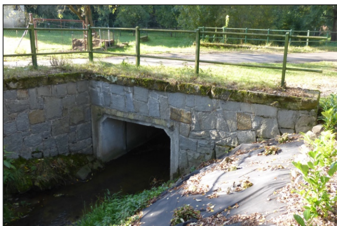
Propustek 1c - staničení 0,052 - pohled zleva
