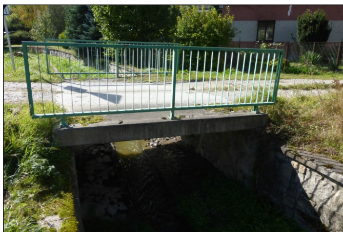
Most 11c-M1 - staničení 0,008 - pohled zprava
