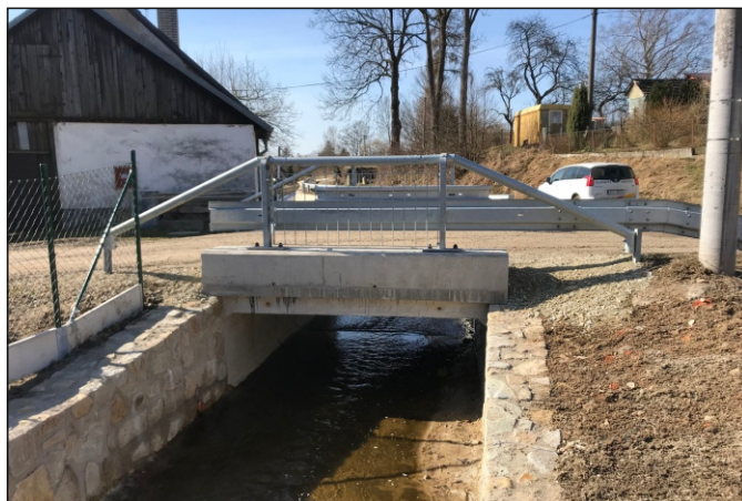
Most 14c-M1 - staničení 0,032 - pohled zprava
