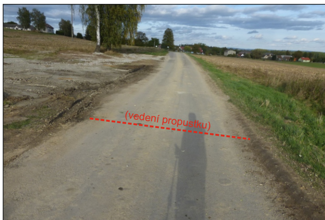
Propustek 22c - staničení 0,440 - celkový pohled
