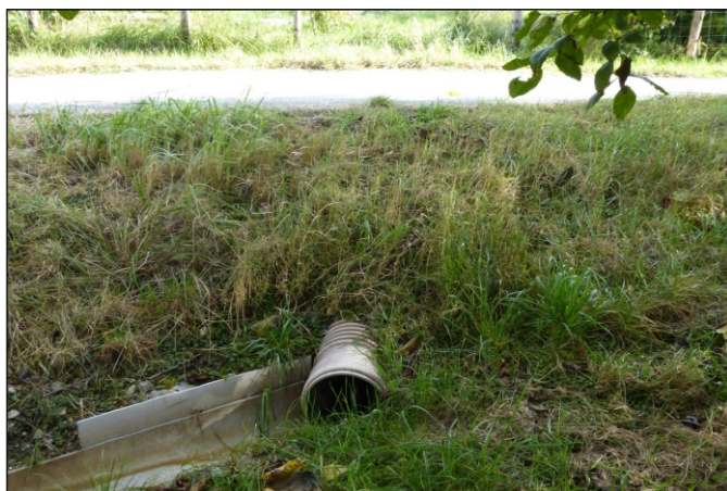
Propustek 5c - staničení 0,144 - pohled zleva
