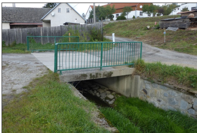
Most 7c-M1 - staničení 0,043 - pohled zprava
