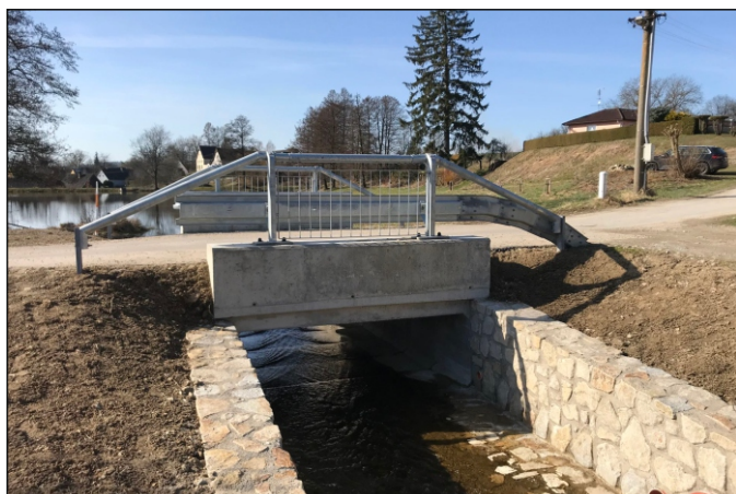
Most 12c-M1 - staničení 0,067 - pohled zprava
