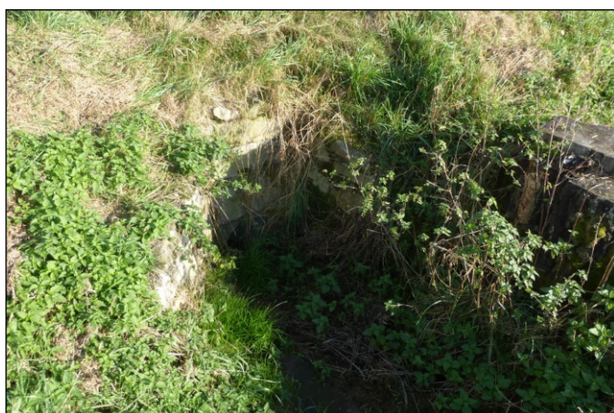
Propustek 1b - staničení 0,593 - pohled zprava
