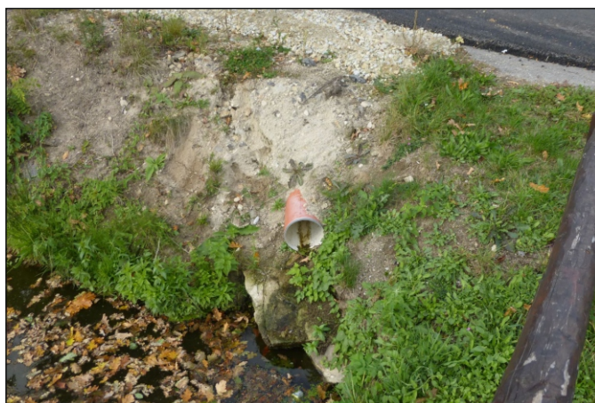
Propustek 23c - staničení 0,311 - pohled zleva
