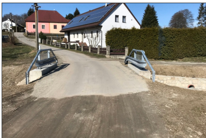
Most 12c-M1 - staničení 0,067 - celkový pohled
