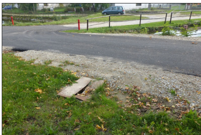
Propustek 23c - staničení 0,311 - pohled zprava
