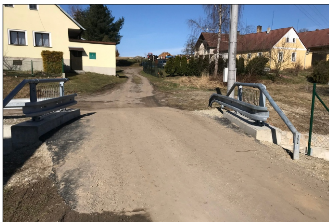
Most 14c-M1 - staničení 0,032 - celkový pohled
