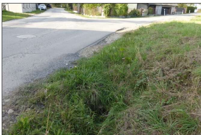
Propustek 1b - staničení 1,671 - pohled zleva
