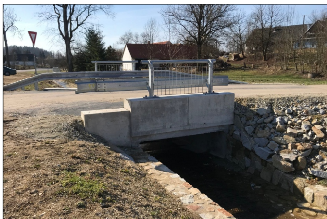
Most 18c-M1 - staničení 0,010 - pohled zprava
